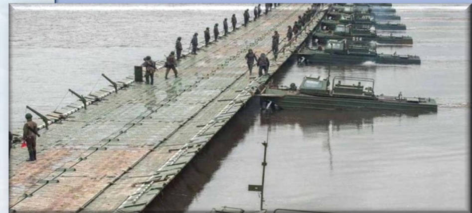
Встановлення понтонної переправи.
