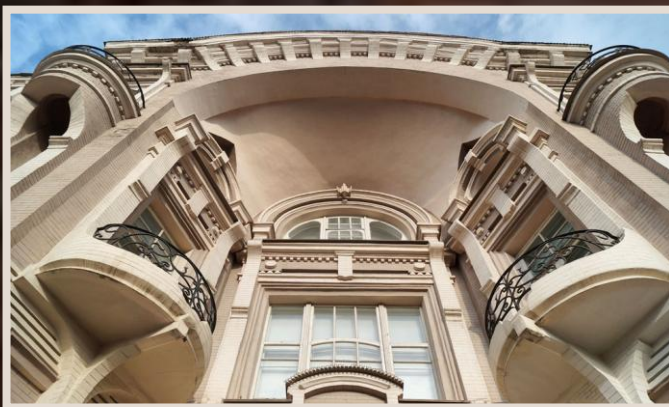
КОВАНІ РЕШІТКИ НА БАЛКОНАХ ПАСАЖУ ШПОЛЯНСЬКОГО А. БАРСЬКОГО [ https://salو.li/5ca33C7 ]
